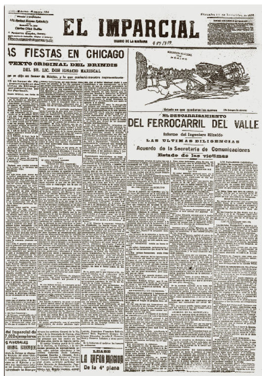
FIGURA 4 “ESTADO EN QUE QUEDARON LOS CARROS”
